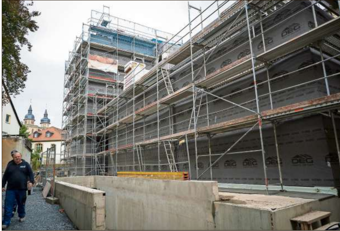
Stadtkirche in Sichtweite, die Regierung in direkter Nachbarschaft: Das höchste leimfreie Holzhaus Bayerns wächst in der Ludwigstraße. Zum Schutz gegen das Wetter ist der Rohbau grau eingepackt. Fotos: Eric Waha
