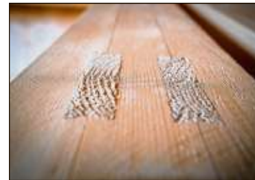
Schwalbenschwanz: Buchendübel verbinden Fichtenhölzer.
