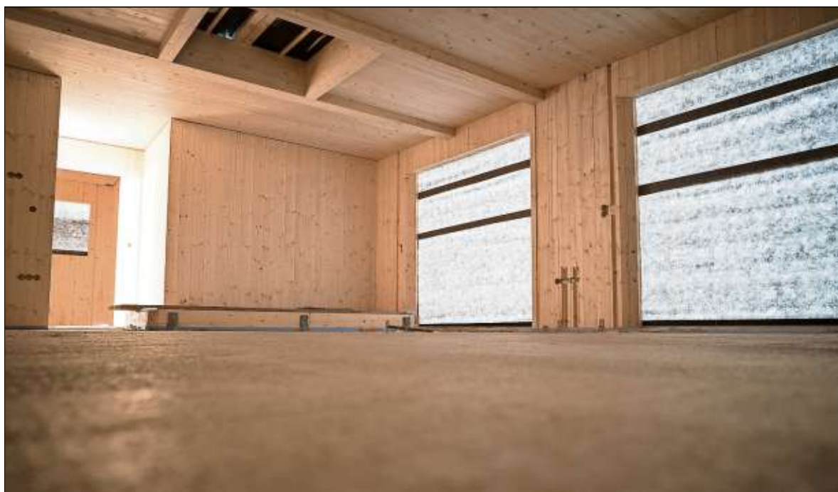
Blick in eine der Wohnungen: Auf den hölzernen Decken gibt es eine Schüttung, darauf einen Estrich – zur Schalldämmung. Der Rest ist Holz. Und darf, in manchen Räumen, auch gut riechen – mit Zirbenholz-Verkleidung.
